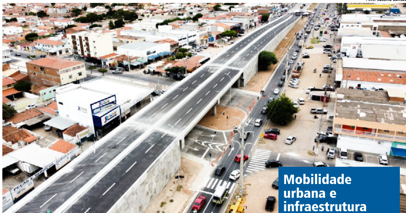
● Novo viaduto na avenida Sete de Setembro integra uma das maiores obras de mobilidade em Petrolina
